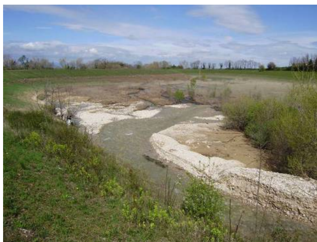
Photographies 4 : Dépôts de sédiments à l'entrée du bassin suite à la crue du 16 avril 2012
