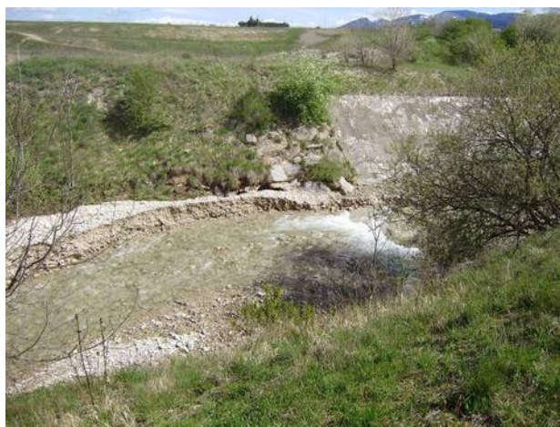
Photographies 4 : Dépôts de sédiments à l'entrée du bassin suite à la crue du 16 avril 2012
