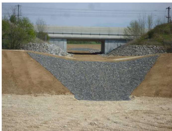
Photographie 2 : Déversoir entre les 2 bassins, sous l'ouvrage de décharge LGV
