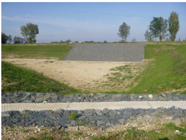
Photographie 1 : Déversoir d'entrée du bassin 1
