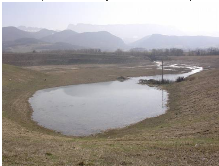
Photographie 3 : Le bassin de Besayes, vue depuis l'aval
