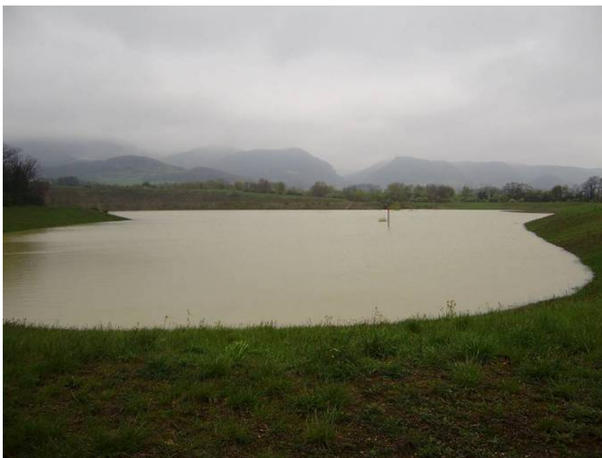
Photographie 5 : Niveau d'eau du bassin de Bésayes le 16 avril 2012
